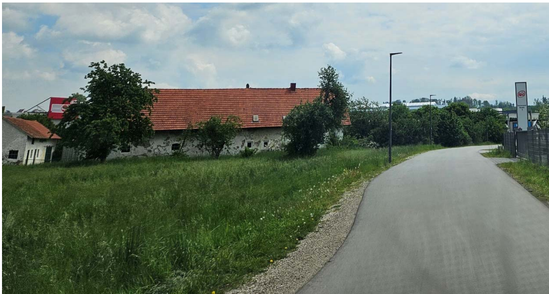
Spörerauer Straße von Nordwesten zur Hofstelle hin mit vereinzelter Gehölzbestand
